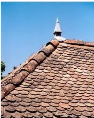
Modèle de tuiles écailles. C'est ce type de tuile qui était sur le lavoir jusqu'en 1990, par rapport aux tuiles violons actuelles.
